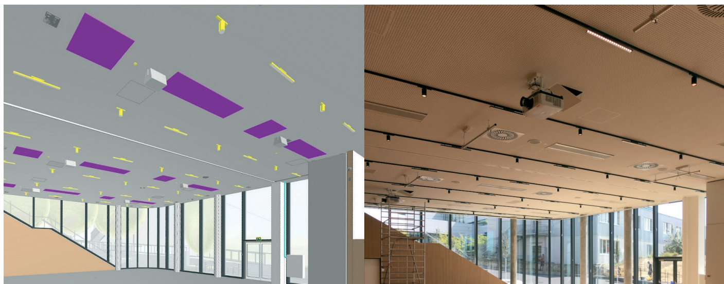
Im As-Built-Modell wurden Abweichungen von +10 Zentimeter toleriert
